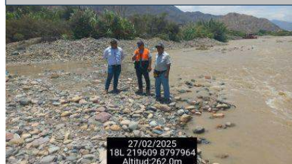
Tramo 6: PANDO Se observa Colmatacion de Piedra, grava y arean en el tramo donde está ubicado la captacion Pando.
