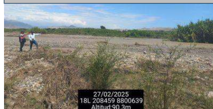
Tramo 2: PALTO PALTITO Se observa Colmatacion de Piedra, grava y arean en el tramo donde está ubicado la captacion Palto Paltito
